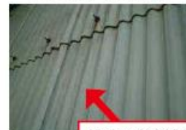
外壁の強度補強
