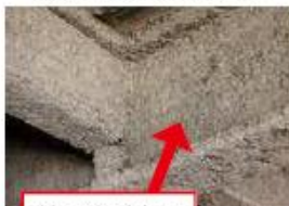
鉄骨の耐火用
