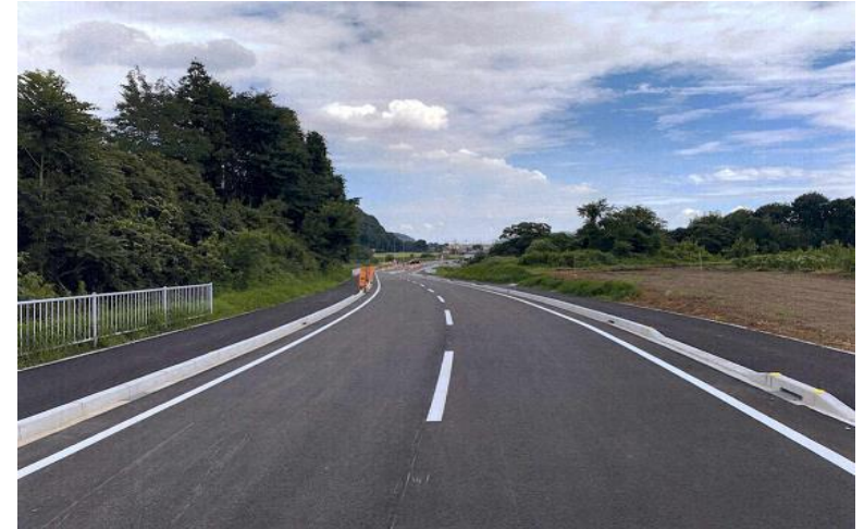
【道路新設工事（市発注）】 盛土から側溝布設、舗装にいたるまで直営班で施工しました。新設道路は、災害時の代替道路の機能を期待し整備されます。
