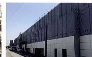
足場工事②
