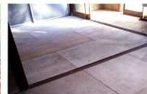
床リフォーム工事
