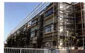
足場工事①
