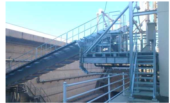
橋および架台据付
