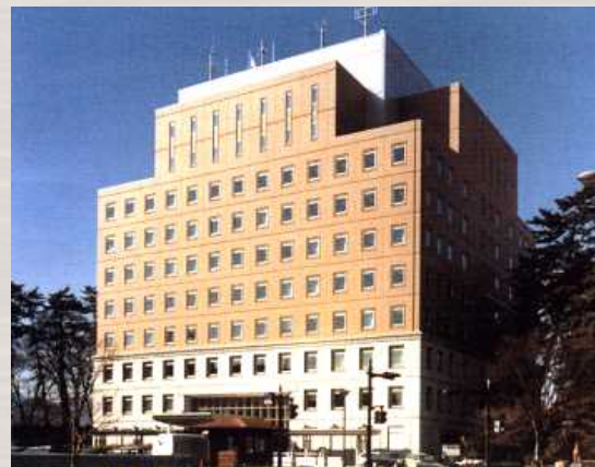
施工例：群馬県警察本部庁舎
