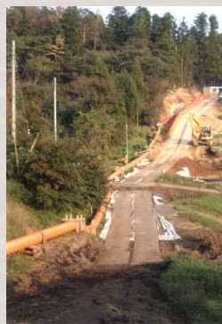
群馬用水管路築造工事
