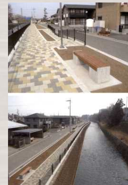
広瀬川遊歩道整備
